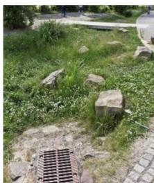
Das Oberflächenwasser wird in den abgesenkten Grünstreifen geleitet und kann dort zeitverzögert versickern. Eine Querung wird über niedrige Brücken ermöglicht.
