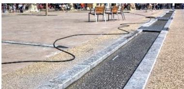
Im Falle eines Starkniederschlagsereignisses kann das Regenwasser nicht vollständig über die Kanalisation abgeleitet werden. Auf Notwasserwegen kann das Wasser zwischengespeichert und in weniger empfindliche Bereiche abgeleitet werden.
